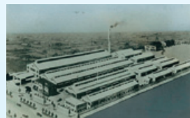
本社・川崎工場全景(1937年)
